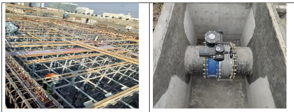
图 3-4 初期雨水池（地埋式、施工过程照片）、切换阀
