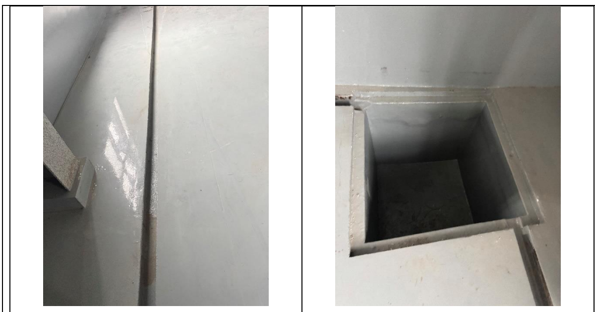
图 3-3 仓库车间设置的收集沟、收集池
