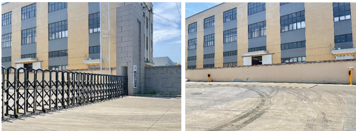
图 3.5-2 固体废物出入口及地磅
